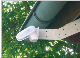
Abb. 7 Beispiel für den Einsatz eines Auslegers: Durch den Gelenk-Ausleger ragt der Sensor unter dem Dachvorsprung hervor.
